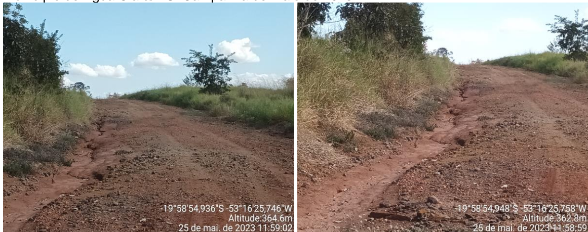
Figura 5. Ponto 3: Erosão em sulcos na lateral da via de acesso, área 2 da PCH Verde 4, no município de Água Clara/MS. Campanha de maio de 2023.
