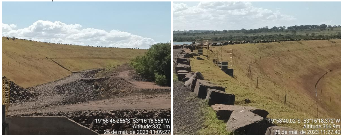
Figura 7. Taludes da PCH Verde 4, contendo área cascalhada e gramada. Município de Água Clara/MS. Campanha de maio 2023.
