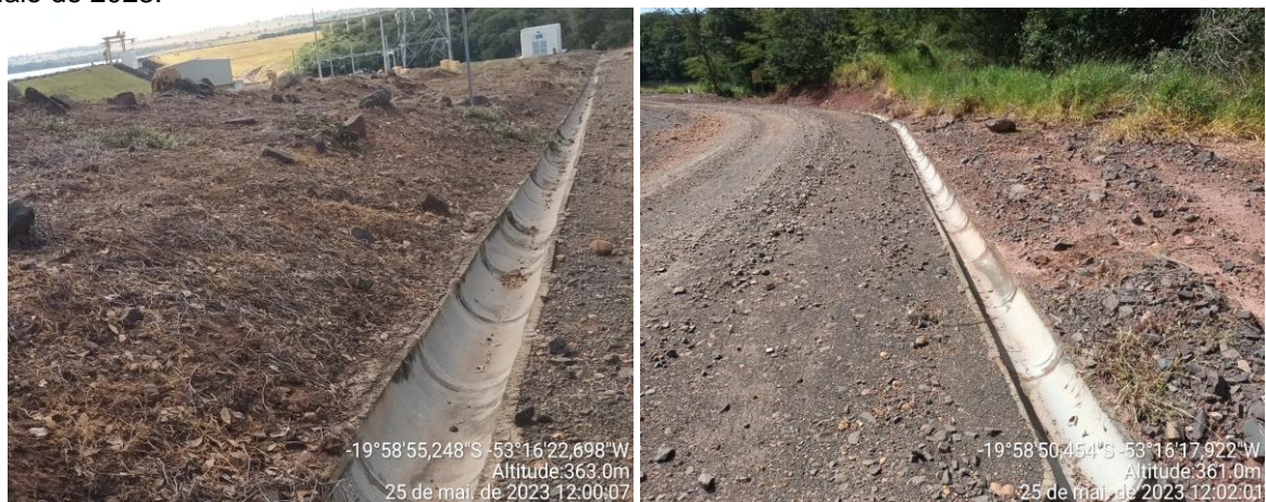
Figura 9. Caneletas de escoamento da PCH Verde 4; Município de Água Clara/MS. Campanha de maio de 2023.
