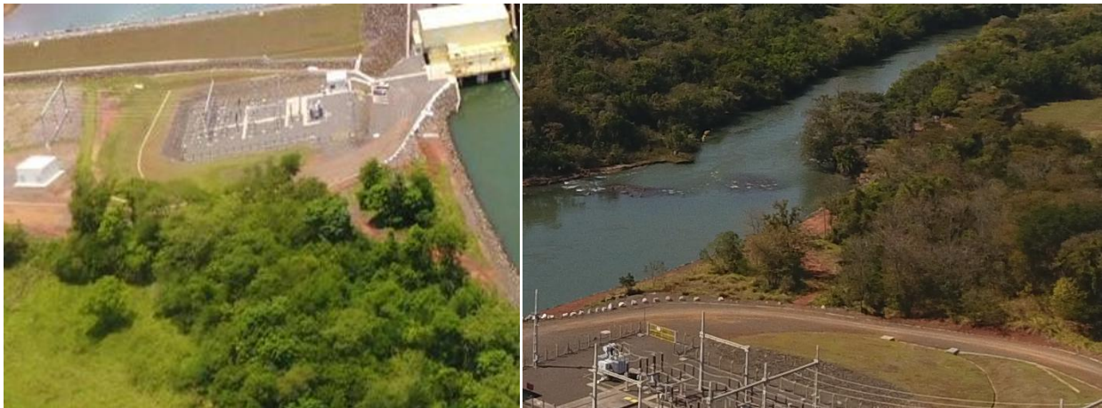
Figura 6 - Imagem aérea da antiga Área do Escritórios de apoio próximo a subestação. Esquerda: 2021; Direita: Junho de 2023.
