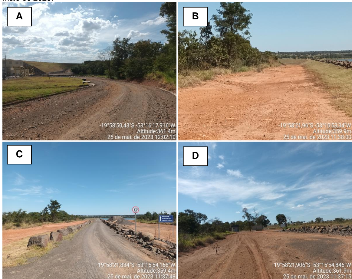
Figura 8. Estradas de acesso interno da PCH Verde 4 em estado apropriado: (A) acesso a casa de força; (B) acesso a margem esquerda da jusante; (C) acesso ao barramento; (D) acesso a guarita e portão; (E) acesso a subestação; (F) acesso a jusante. Município de Água Clara/MS. Campanha de maio 2023.
